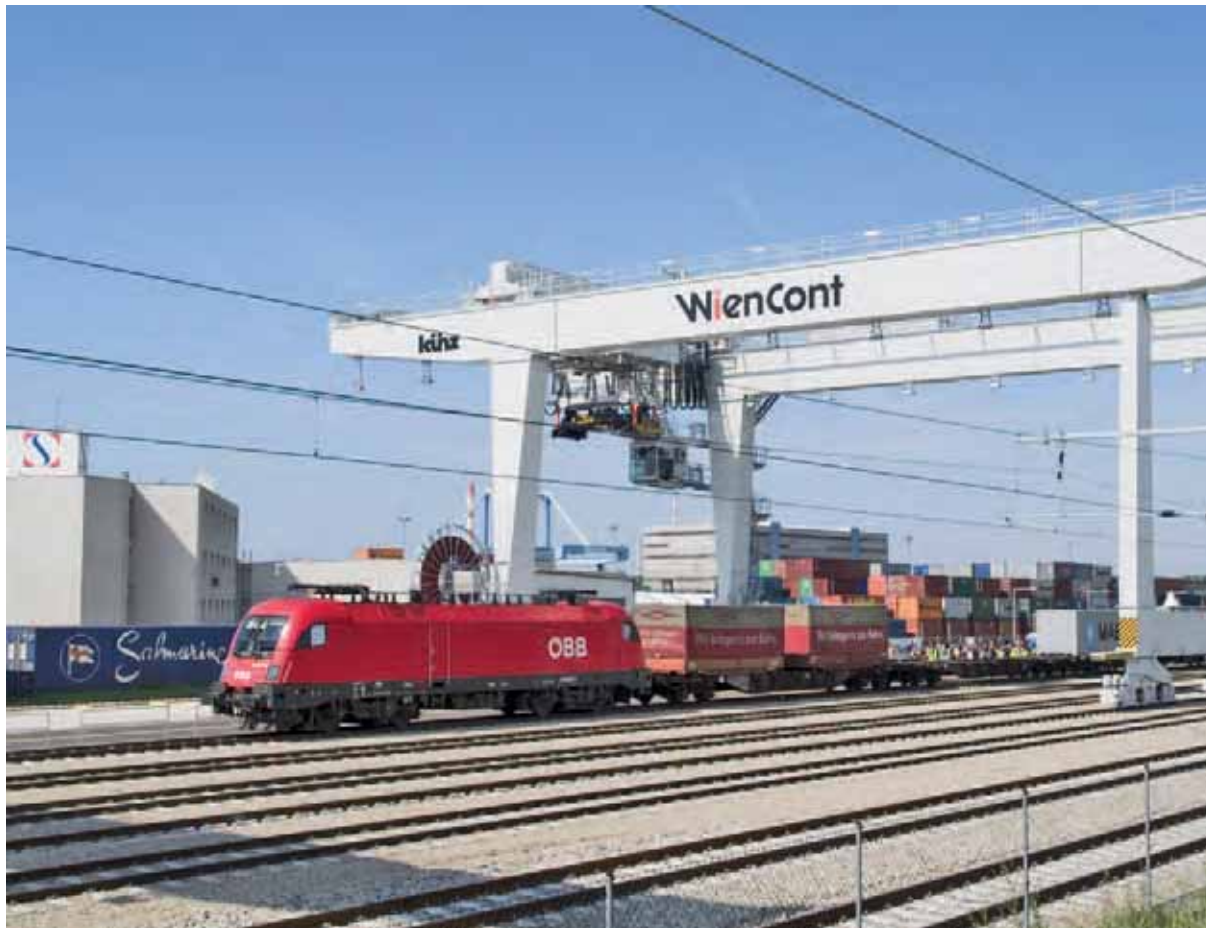
Der Zugang zur letzten Meile ist eine unabdingbare Voraussetzung für die Liberalisierung des Schienengüterverkehrs. Diese betrifft sowohl Anschlussbahnen als auch Terminals, wie das hier abgebildete Containerterminal Wien Freudenau.
