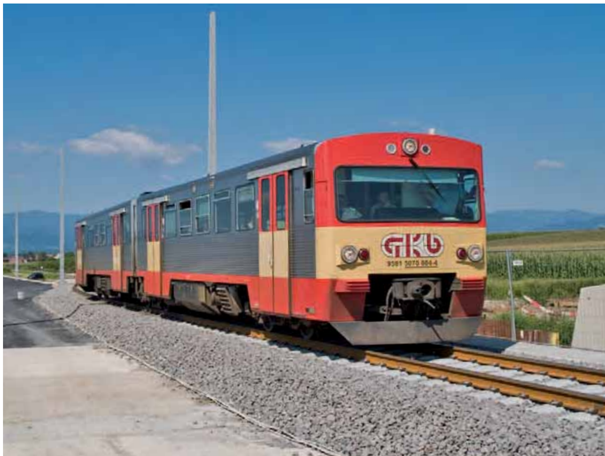
Der Bau der Koralmbahn wie hier bei Wettmannstätten bringt auch eine neue Verknüpfung mit der Infrastruktur der GKB
