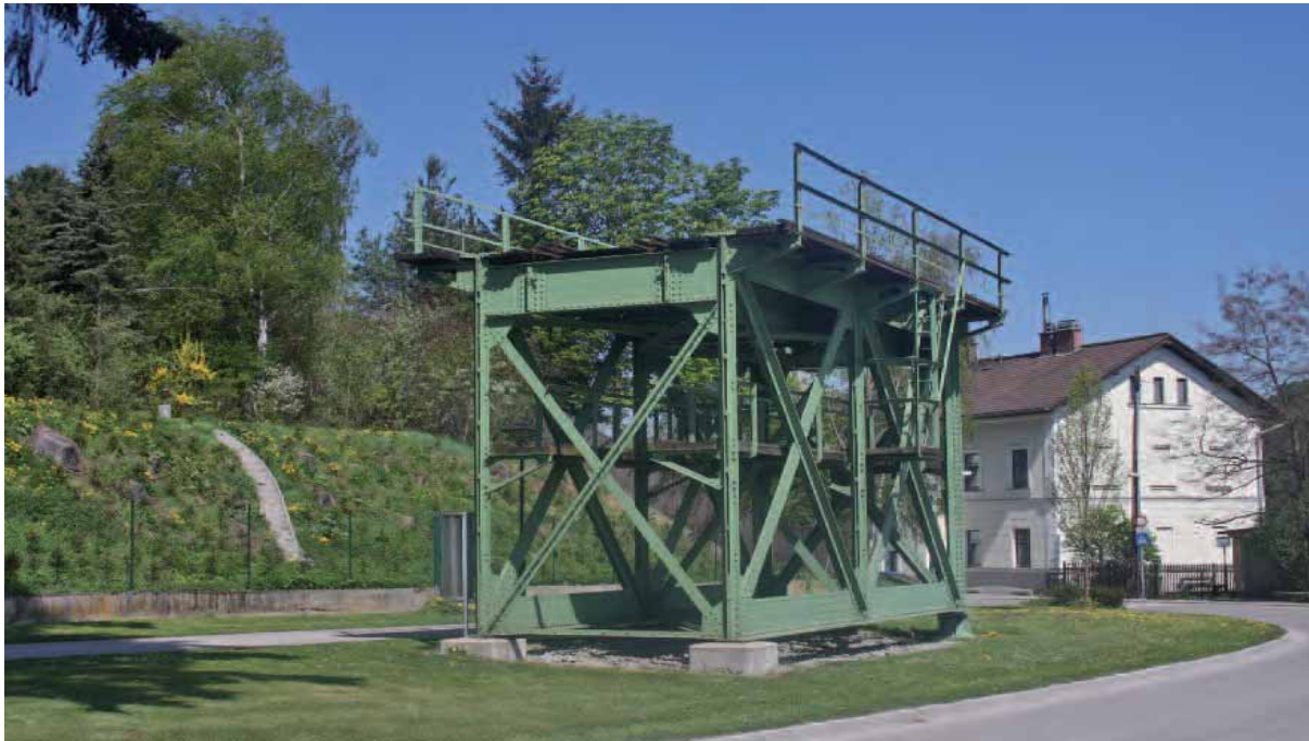
Eine Wesentliche Aufgabe der SCHIG stellt die technische Infrastrukturkontrolle gemäß §43 und §45 Bundesbahngesetz dar. Die hier abgebildeten Teile der Fachwerkbrücke in Zwettl oblagen einst auch dieser Kontrolle.
